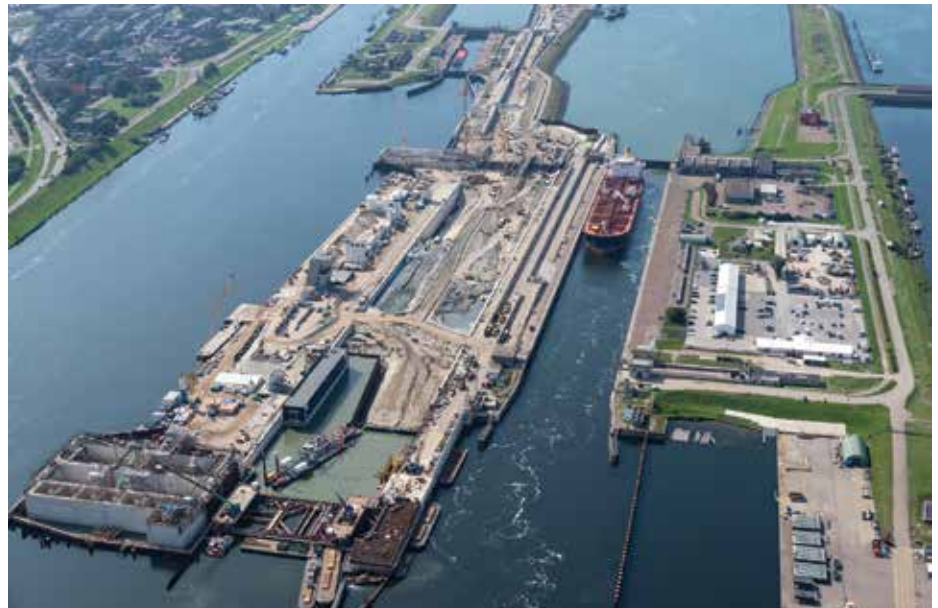
4. Bouwplaats middenin bestaand sluiscomplex (februari 2018).
