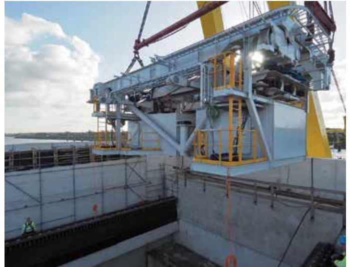
17. Bovenrolwagen op de deurkas geplaatst (foto: Ko van Leeuwen).
