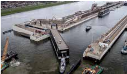
24. Invaren sluisdeuren in binnensluishoofd (foto's: Drone Addicts).
