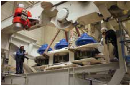
20. Montage aandrijftrein in bovenrolwagen.
